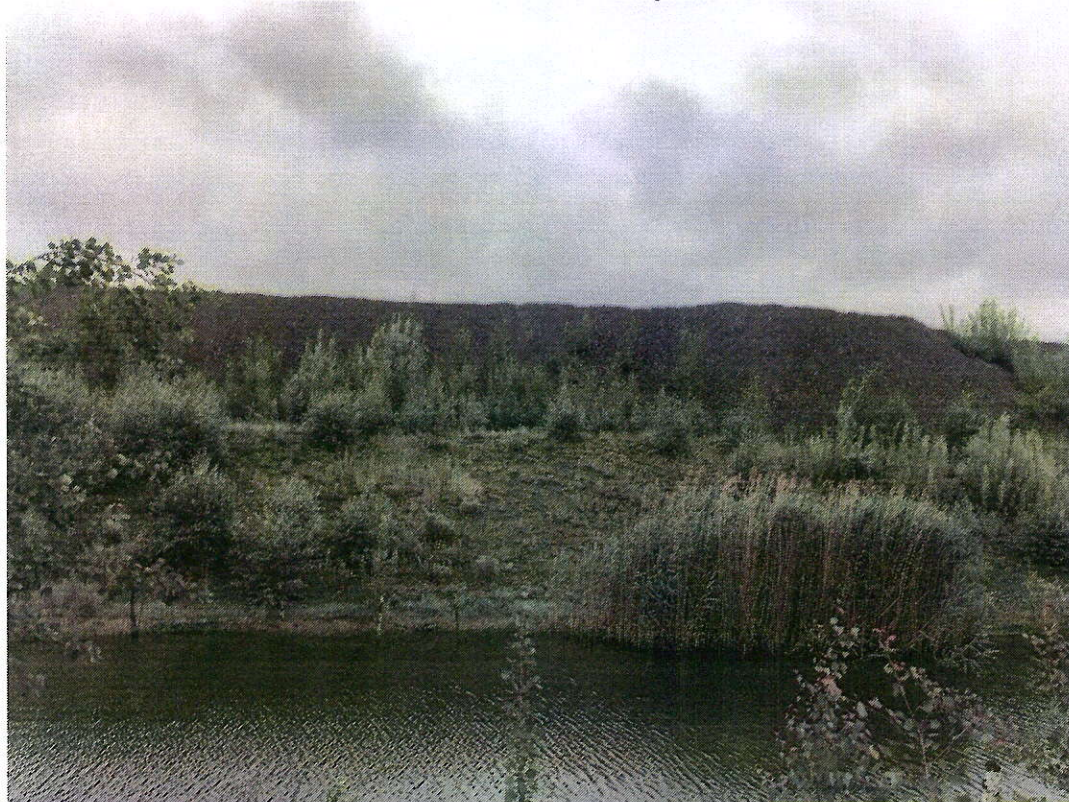
Hráz kalové nádrže „G“ v jižní části
